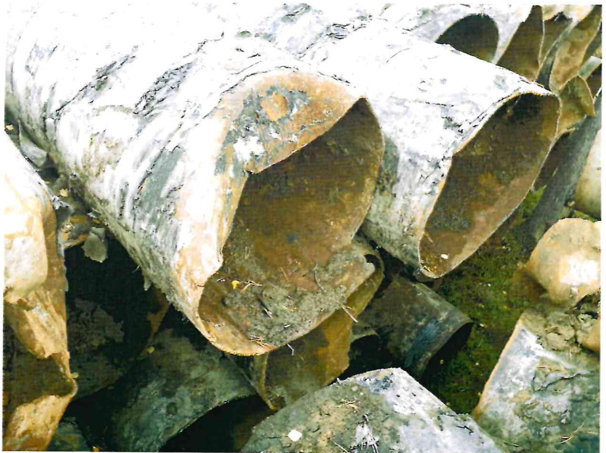
Фото №31,32. Деформация стенок труб.
