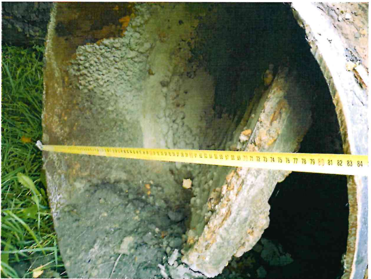
Фото №17,18. Замеры габаритов арматуры.
