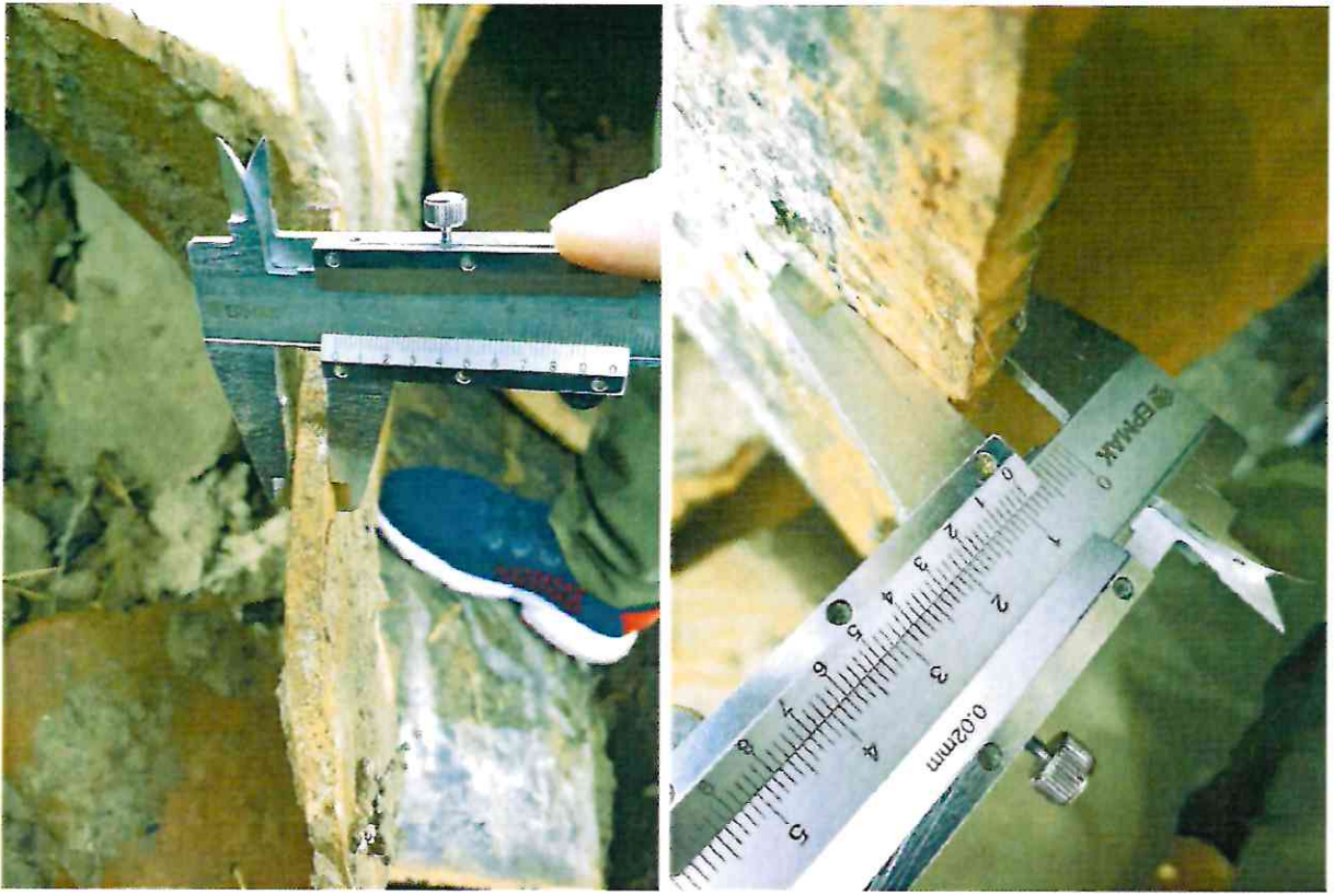
Фото №13,14. Замеры толщины стенок труб.
