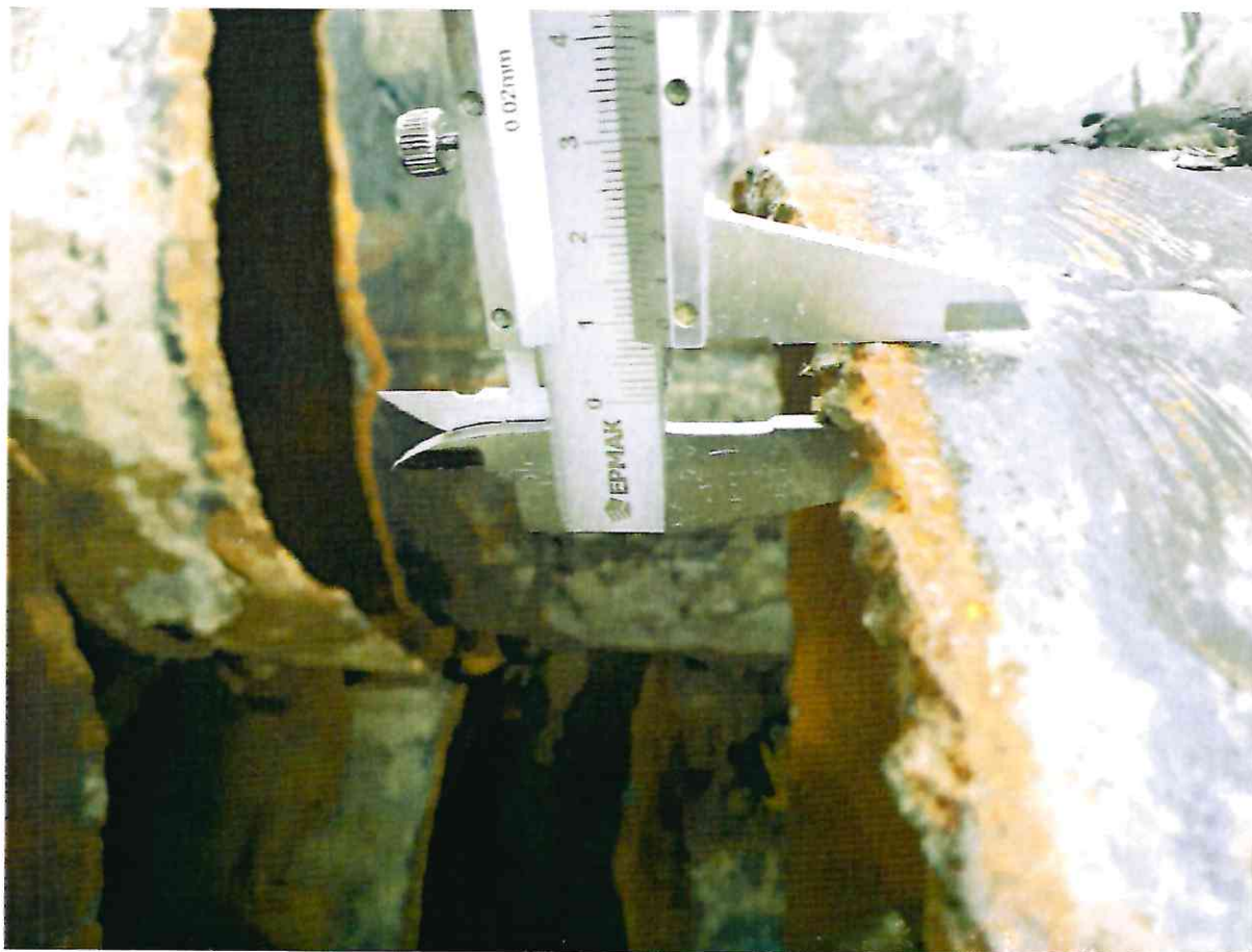
Фото №11,12. Замеры толщины стенок труб.
