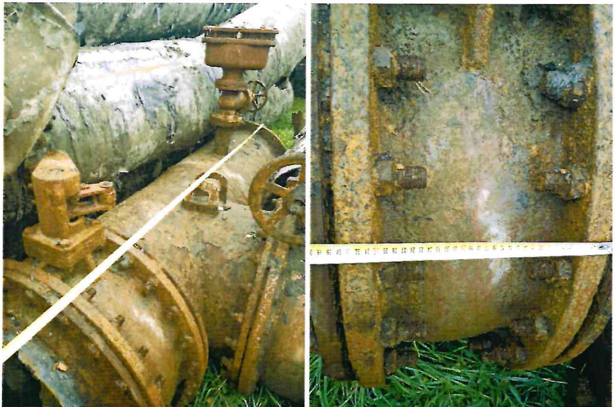
Фото №15,16. Замеры габаритов арматуры.
