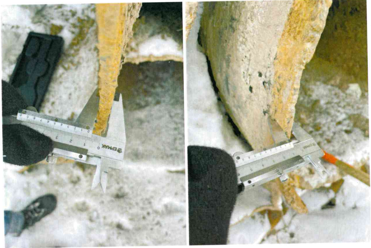
Фото №33,34. Замеры толщины стенок труб.
