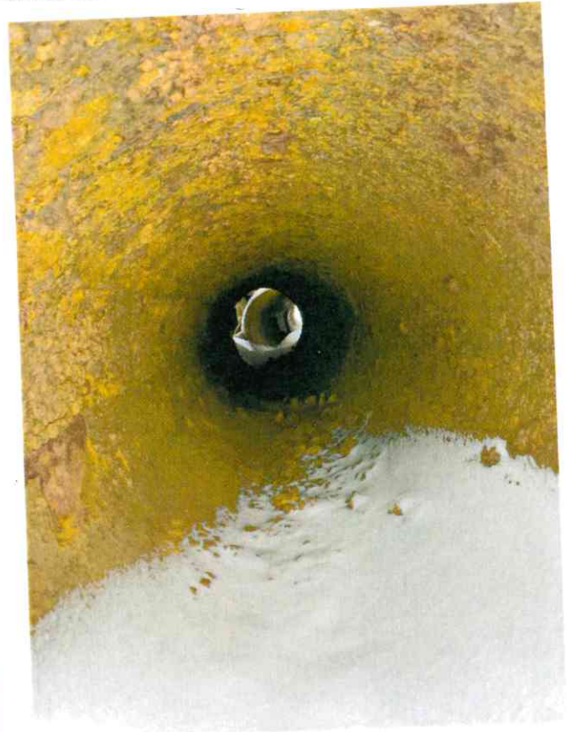
Фото №21,22. Состояние внутренних стенок труб (отложения на стенках, коррозионные повреждения).
