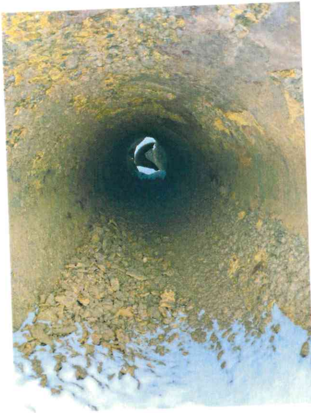
Фото №21,22. Состояние внутренних стенок труб (отложения на стенках, коррозионные повреждения).
