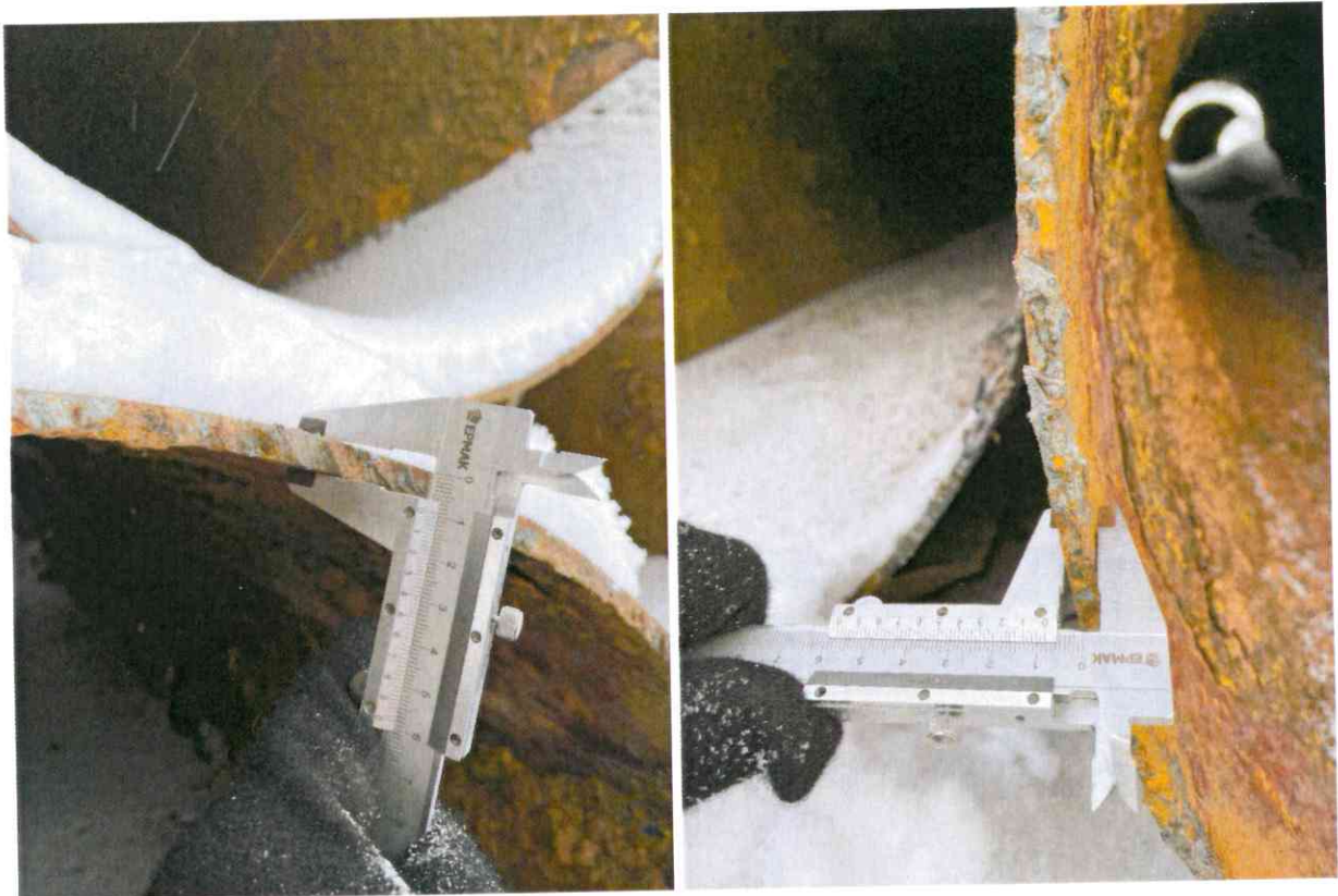
Фото №35,36. Замеры толщины стенок труб.
