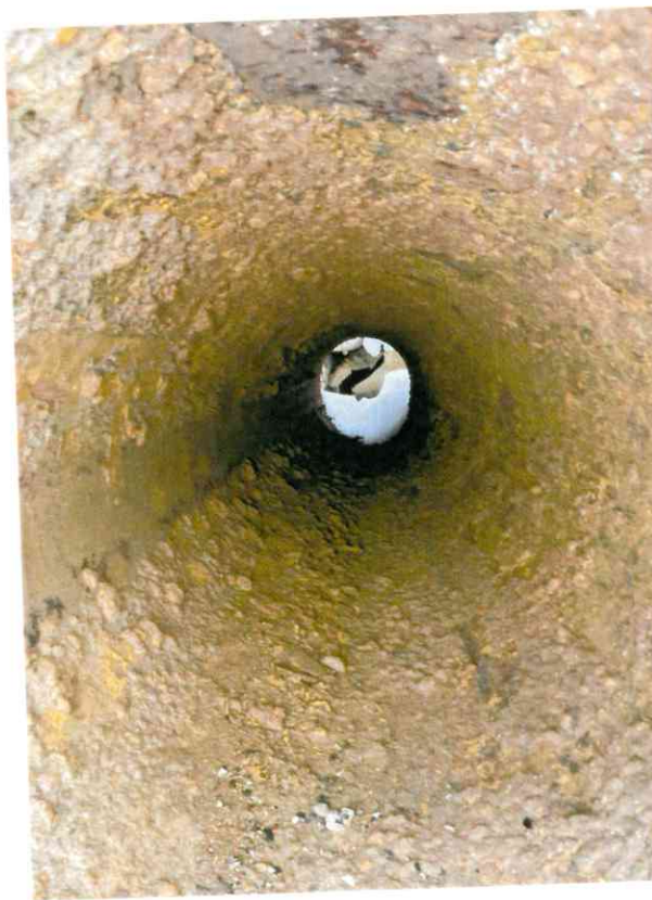
Фото №23,24. Состояние внутренних стенок труб (отложения на стенках, коррозионные повреждения).
